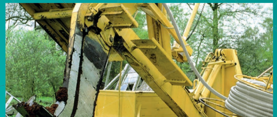
Innovatives Verlegeverfahren (REHAU)
